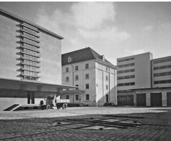
Magazin 2 und 3, Bau 1, Aufnahme 1934/35
